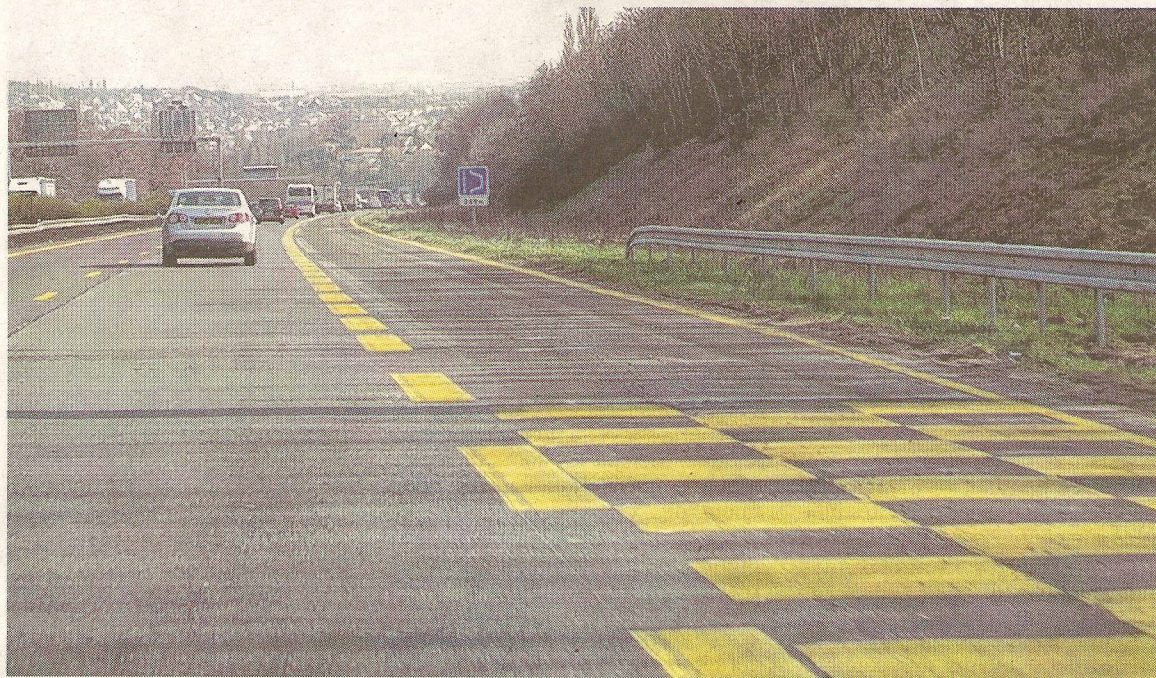
AUTOURROUTE A 10, HIER. C'est sur ce tronçon matérialisé en jaune que les bus des lignes 91.02 et 91.03 peuvent rouler en cas d'embouteillages. (LP/C.CH.)
